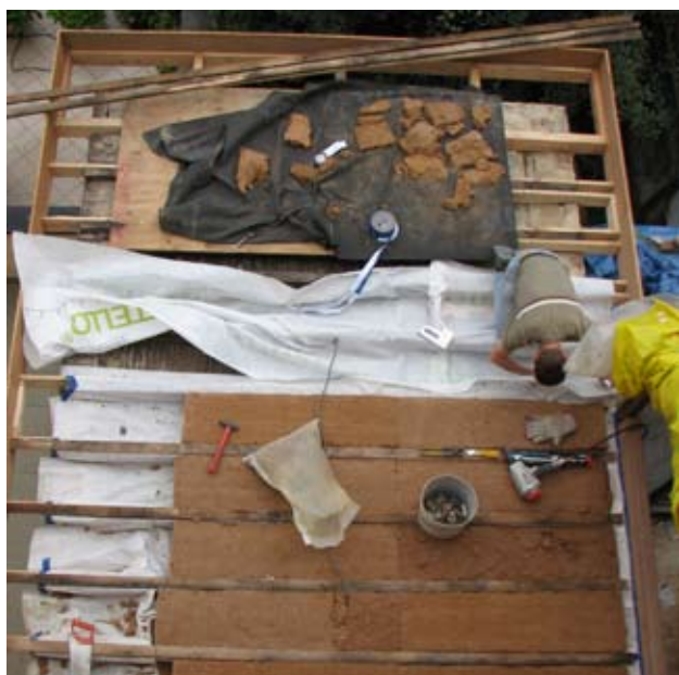
Toiture plate : pose du freine-vapeur et de l'isolation.
