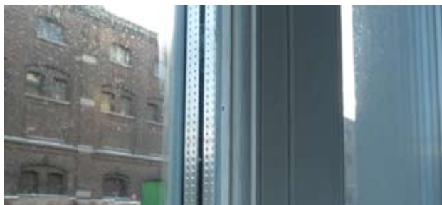
Châssis en chêne avec triple vitrage.
