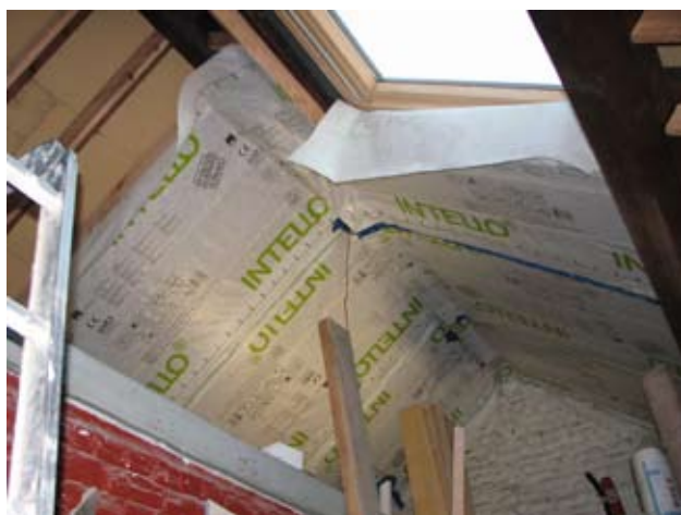
Toiture à versants : pose de la sous-toiture et du freine-vapeur. La cellulose doit encore être insufflée.
