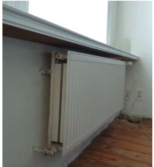
Isolation et finition des allèges de la façade à rue.
